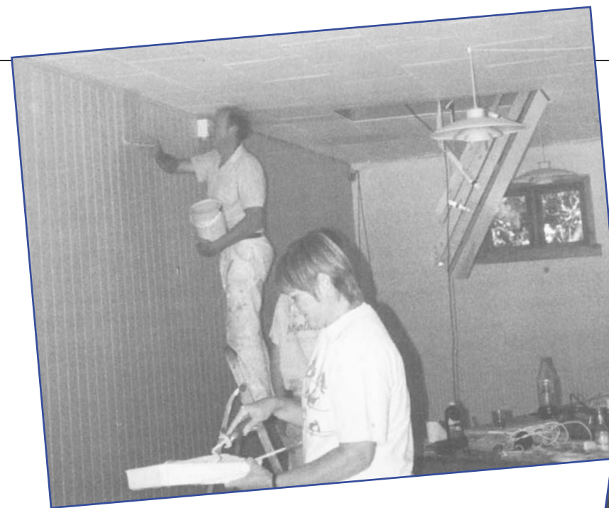
Renovering i 1995 - Lisbeth Bothmann og Peter Baundal under malerarbejdet
